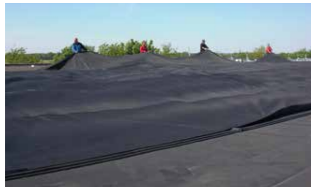
Het plaatsen van een membraan.
