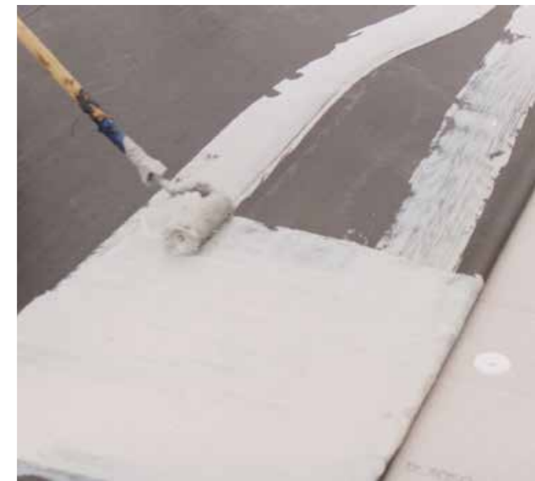
Zelfklevende met SBS-bitumen gecacheerde EPDM-dakbanen worden gekleefd op een ondergrond, die is voorbehandeld met een synthetische primer.
