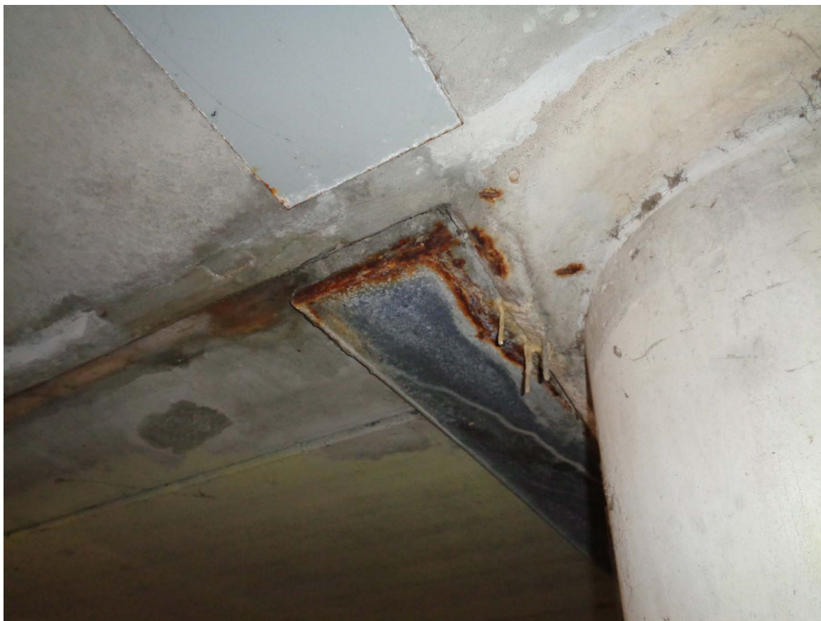
▲ Figuur 14: Roestvorming op de ligger onder de hellingbaanconstructie in 2023. (Bron: onderhoudsadviesbureau van de huidige gebouweigenaar)
