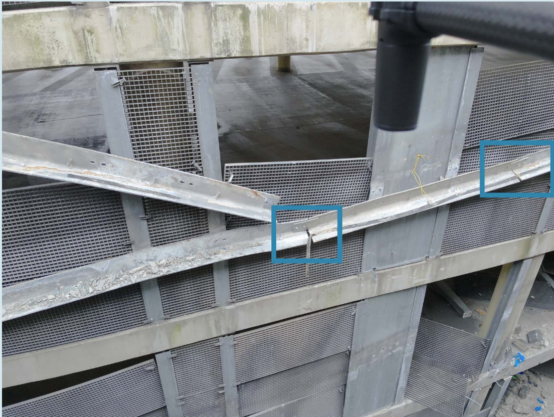
▲ Figuur 13: In delen geknipte ligger met bouten en aangelaste plaat. (Bron: Onderzoeksraad voor Veiligheid)
